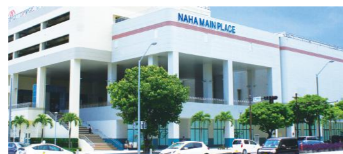
一日当たりの来場車両数が最大約12,500台の6階建て自走式立体駐車場
